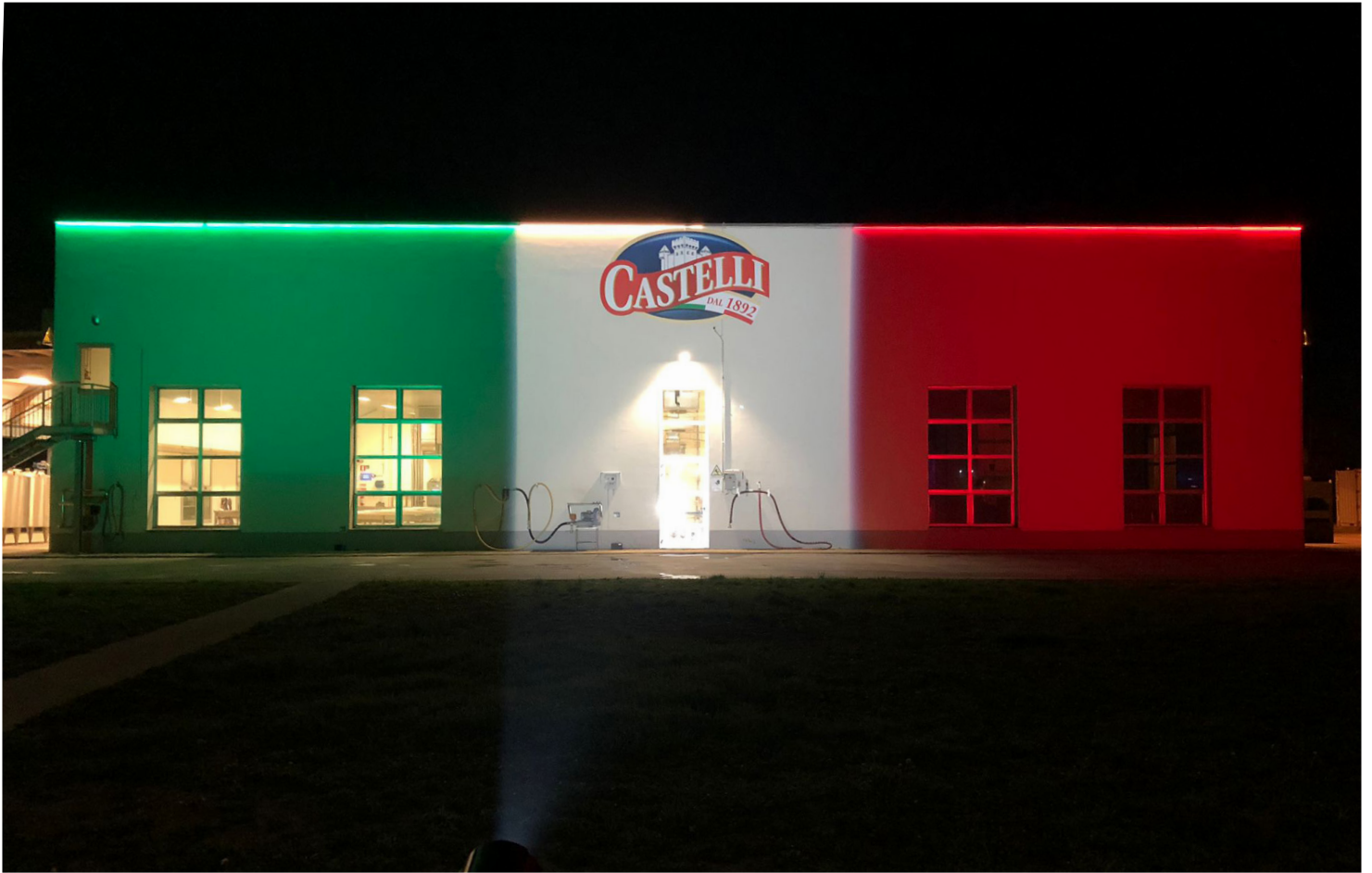
Architetture da esterno - Antico Caseificio Tricolore, Italia
