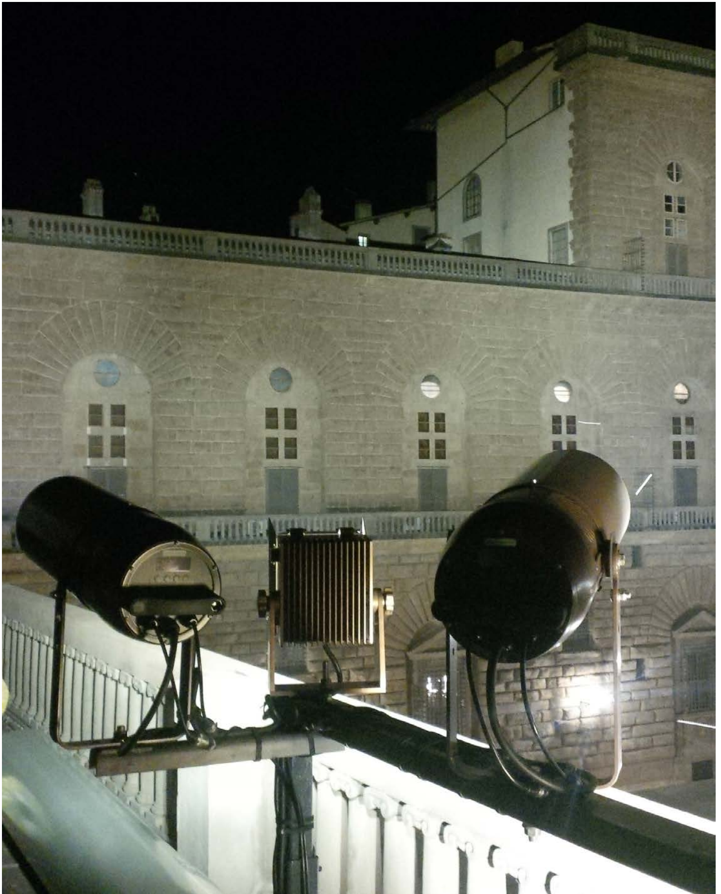
Architettuale da esterno - Palazzo Pitti, Firenze, Italia
